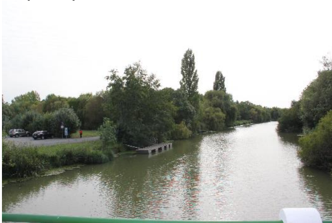
depuis le pont situé à l'amont
